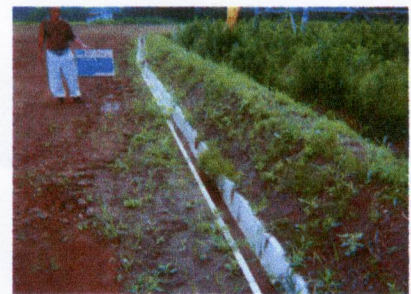
平成18年9月 植栽・外構工事
