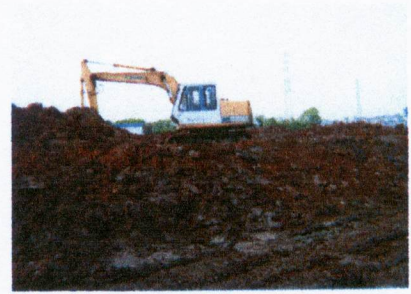
平成18年2月～8月初旬 盛土工事
