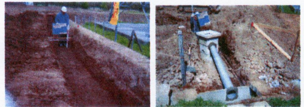
平成18年8月中旬 敷地・ネット・支柱工事 雨水配水工事
